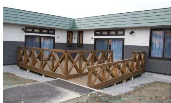
特別養護老人ホーム ウッドデッキ
